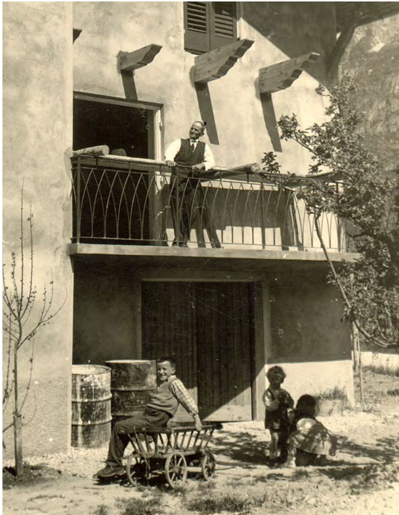
Langsam geht es aufwärts: mein Schwiegervater Richard beaufsichtigt den Bau des neuen Hauses am Moosweg.
